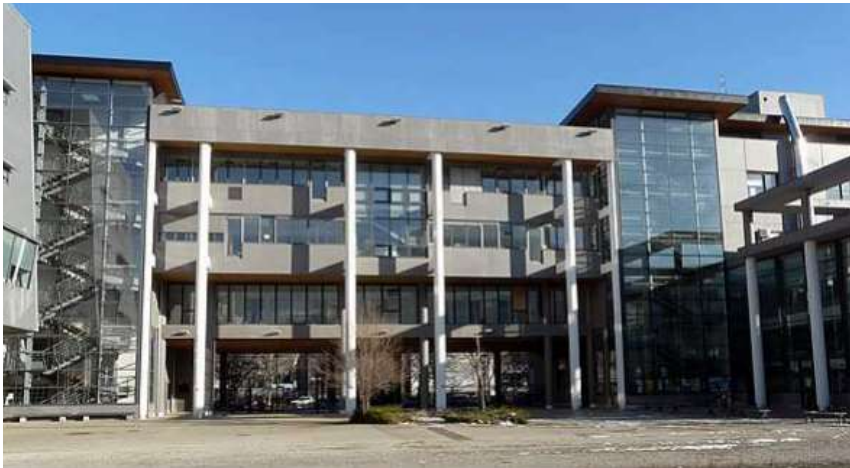
Vue depuis la Cité des Territoires (intérieur de la Cité des Territoires)
